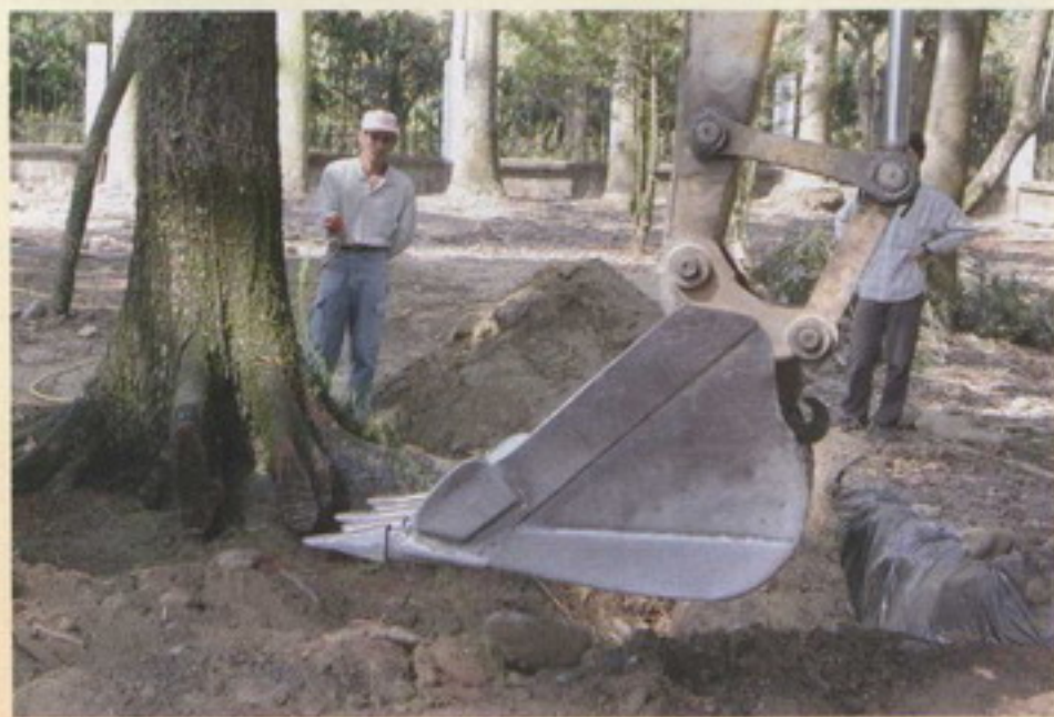
◎圖十四 挖掘阻斷溝深約1公尺，並以強力塑膠布阻隔後回填土壤。
